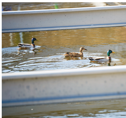
Utrip na Centralni čistilni napravi Kranj / Foto: Samo Paušer
